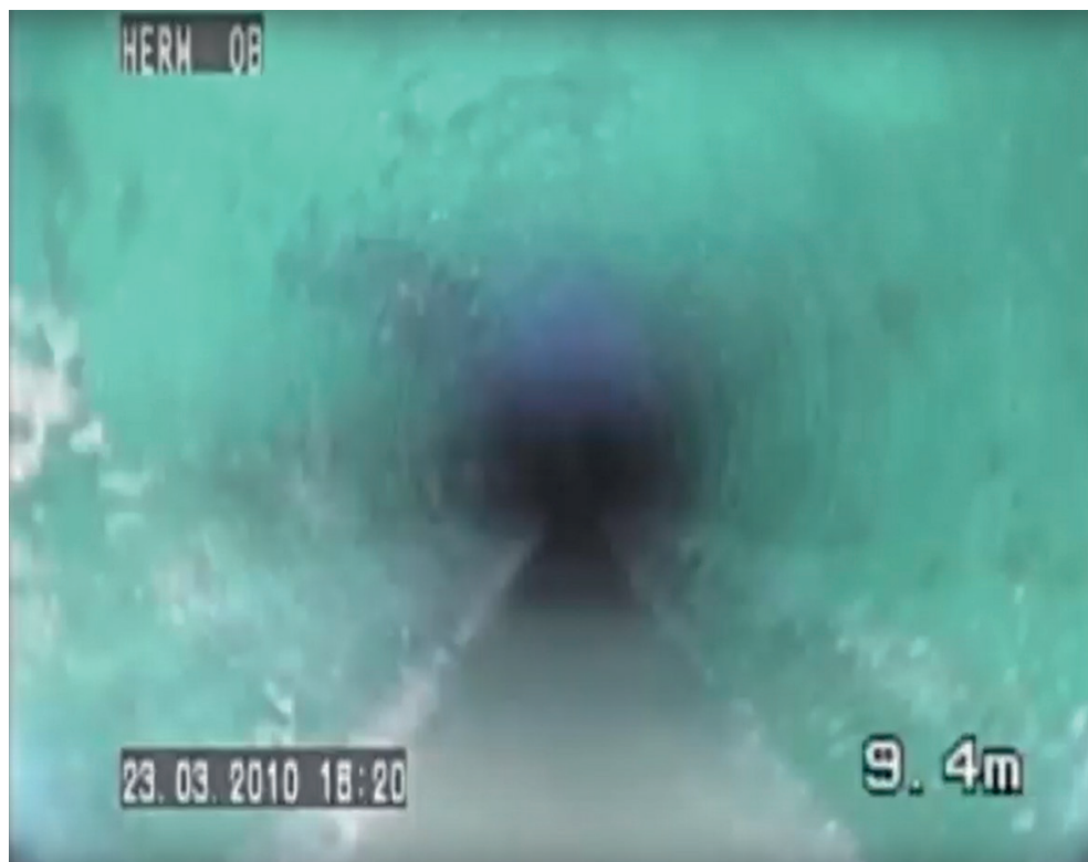
Abbildung 2: Fettverstopfung nach Reinigung (Youtube, 2024)
