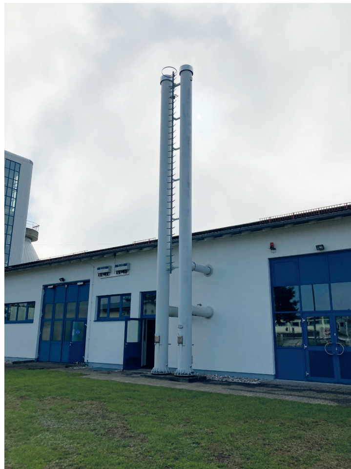
Abbildung 8: Schornsteine von Block- heizkraftwerken, z. B. auf der Kläranlage Schwandorf-Wackersdorf1
