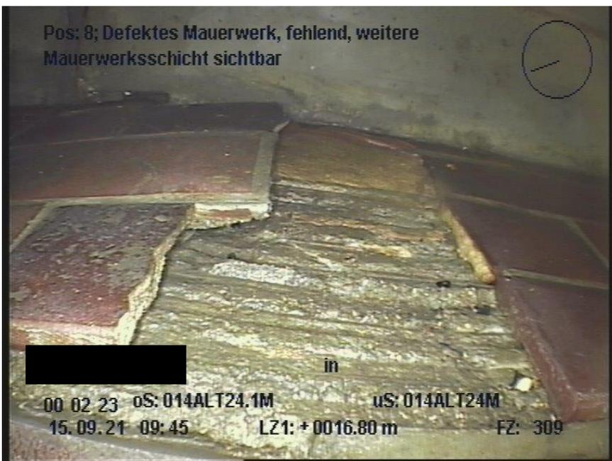
Abbildung 14 Defekte Seitenwand in einem Kanal in Freising<sup>14</sup>
