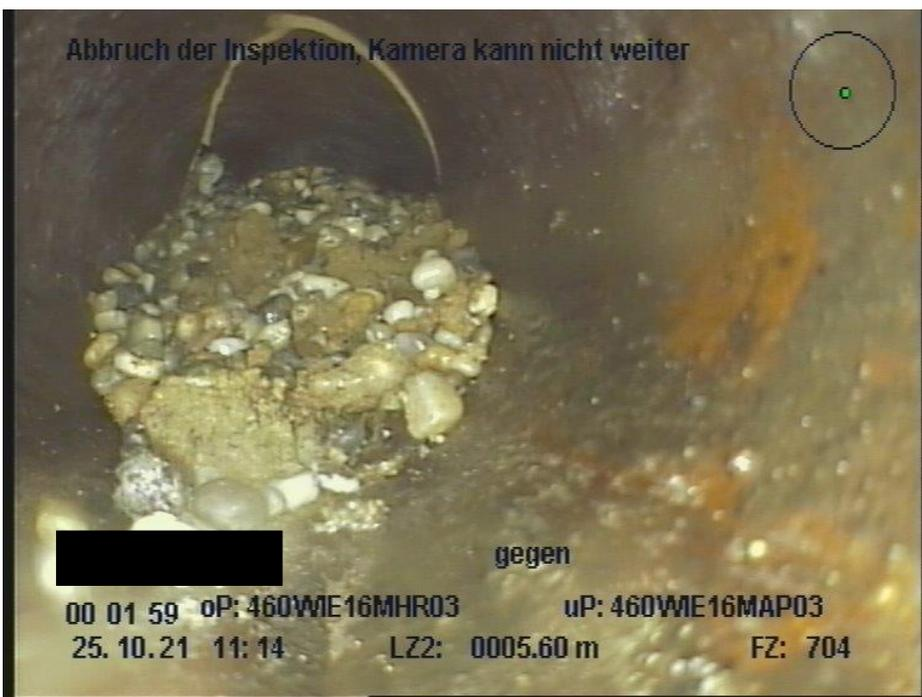
Abbildung 16 Kieseintrag im Kanal in Freising<sup>16</sup>
