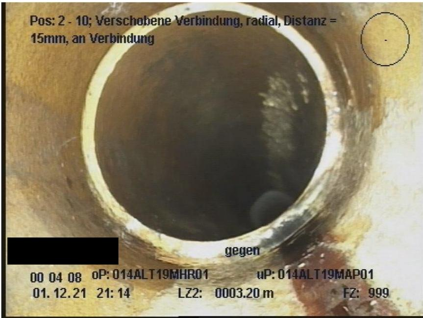
Abbildung 13 Kanalrohr verschoben in einer Straße in Freising<sup>13</sup>
