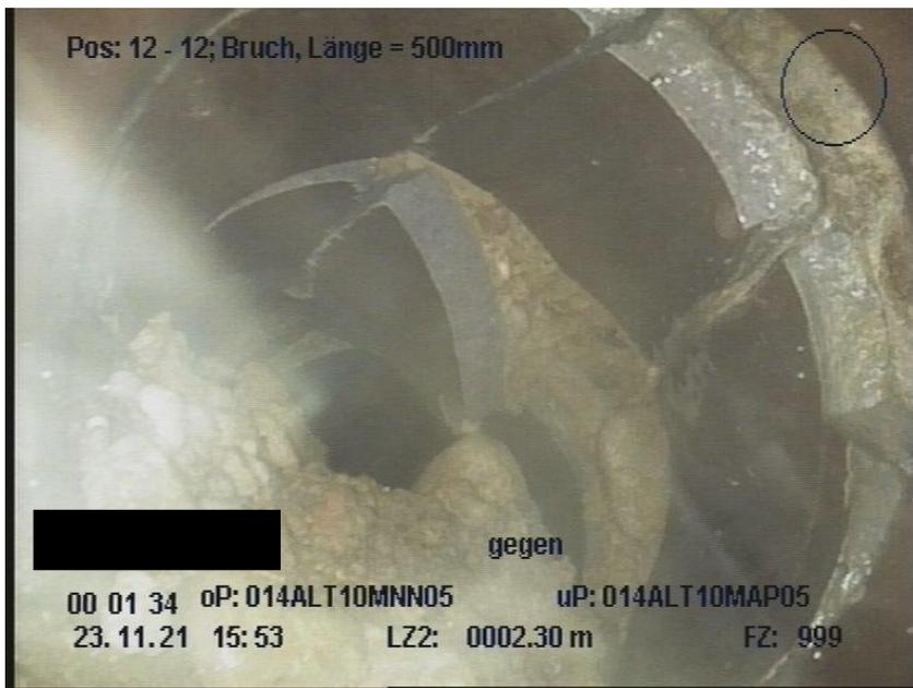
Abbildung 11 Zerbrochenes Kanalrohr in einer Straße in Freising<sup>11</sup>
