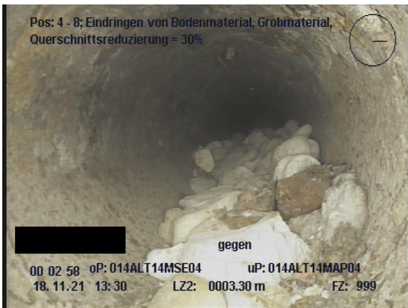
Abbildung 12 Kieseintrag im Kanal in einer Straße in Freising<sup>12</sup>
