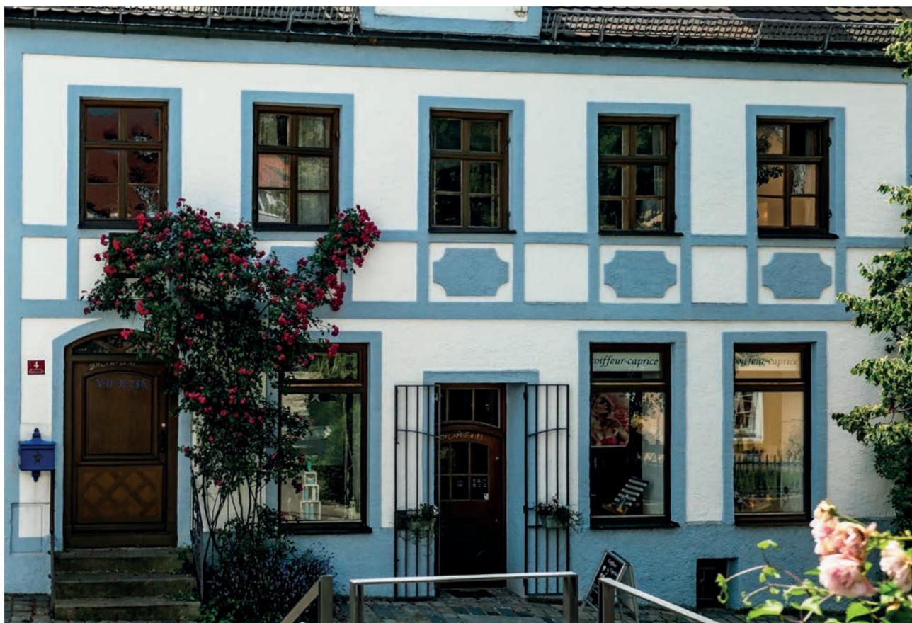
Erdgeschosszone durch verputzte Mauerwerkssockel und Wandpfeiler in „Schaufenster“ und Eingang gegliedert.
