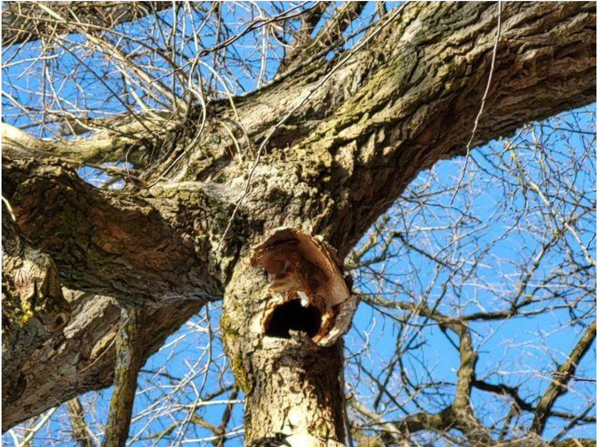
Abb. 4 Baum Nr. 482, Pappel, Abbruch Seitenast und waagrechter Reststumpf
