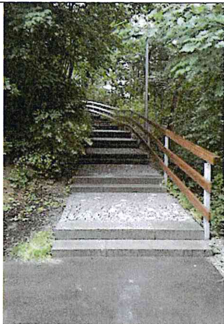
Treppe zum Spielplatz Nicht Kinderwagen gerecht, Rampe einbauen
